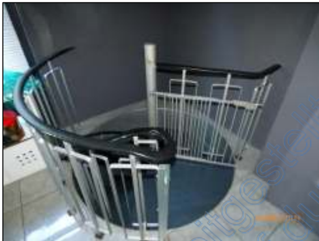
Ansicht: Zugang UG (Bild 10)
