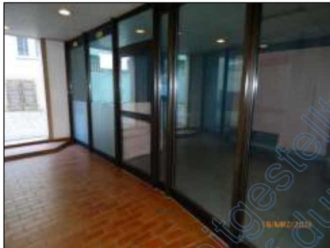
Ansicht: Passage Ladeneinheit Nr. 6 (Bild 4)
