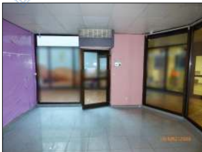
Ansicht: Laden Nr. 5 - Klimaanlage (Bild 6)
