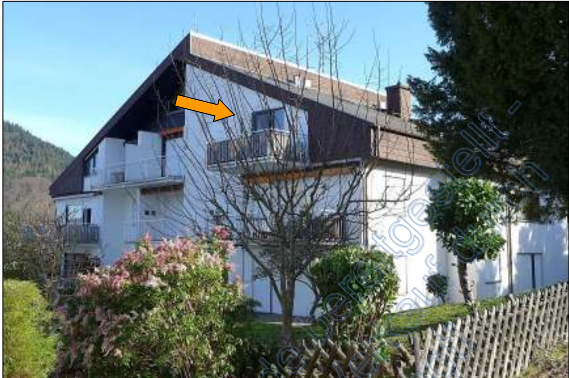
Bild 3 – Balkonseite, Blick von Südwesten
