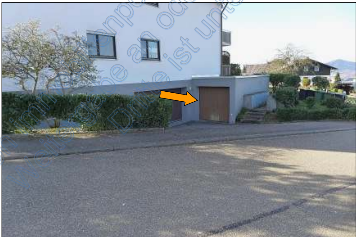
Bild 4 – Einfahrt Tiefgarage und Garage
