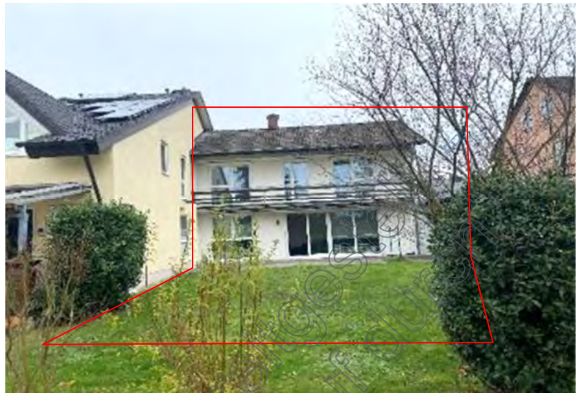
Foto 3 des SV: Ansicht von Südwesten, Hausrückseite
