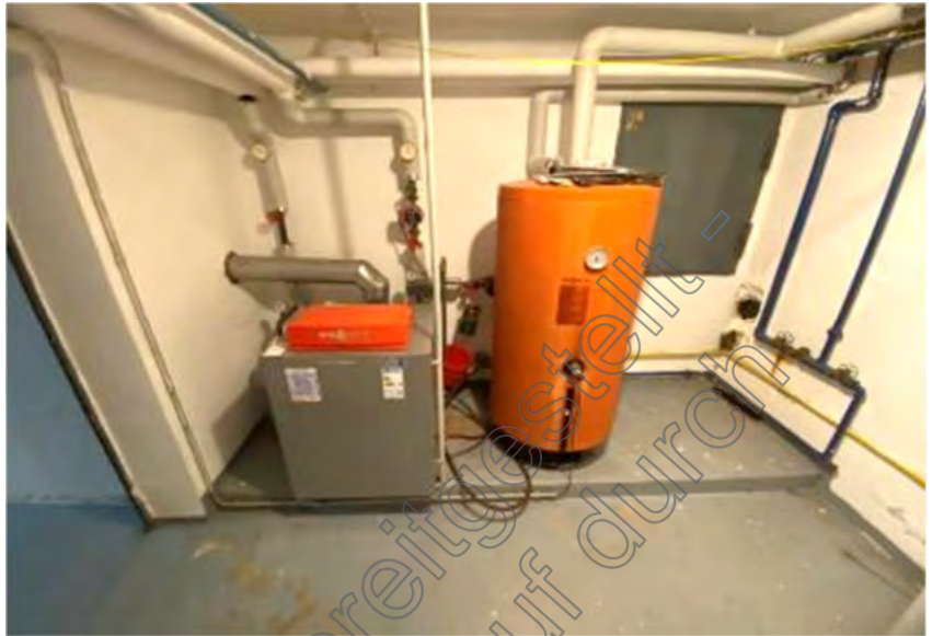
Foto 18 des SV: KG, Heizraum
