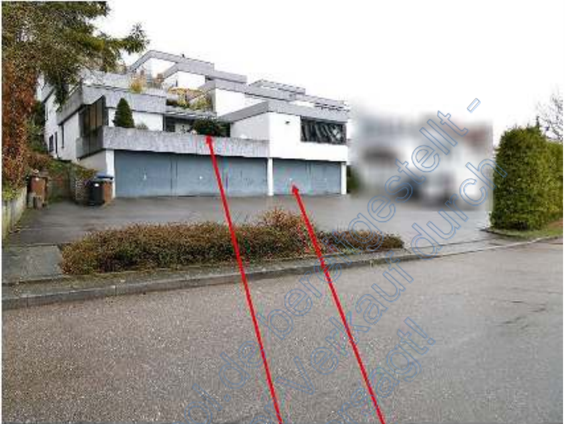
Ansicht Südwest Wohneinheit 1 Garage 1
