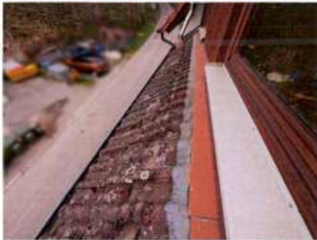
Außenansicht Dach vom Dachgeschoss
