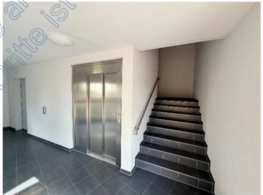
Foto 4 des SV: Goethestraße 37 (Haus 1); EG, Treppenhaus und Aufzug
