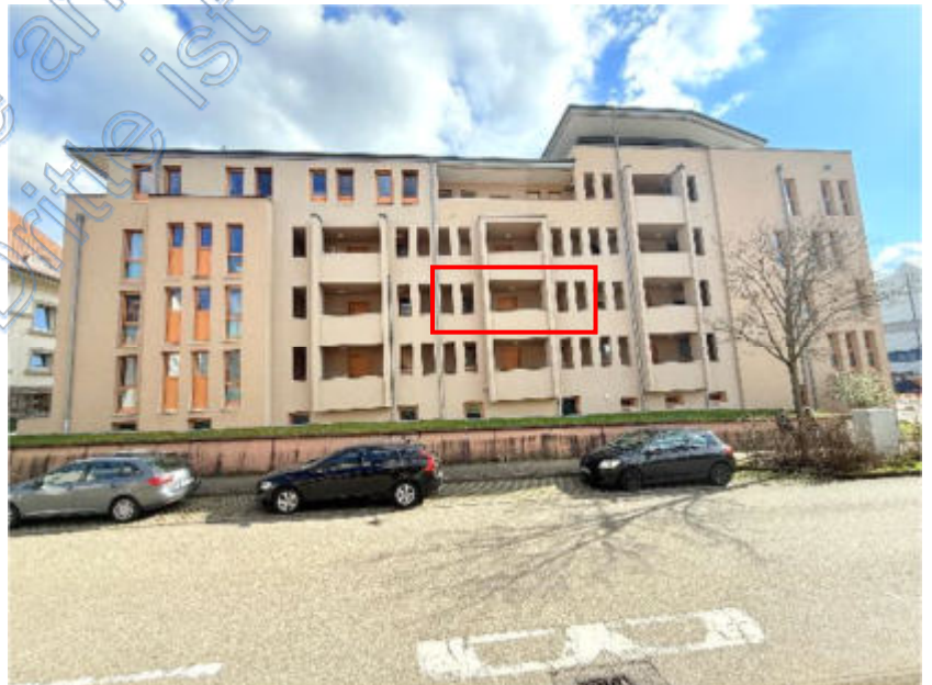
Foto 2 des SV: Goethestraße 37 (Haus 1); Ansicht von Nordwesten, von der Michelbacher Straße; Detail Wohnung Nr. 01.06; Rotmarkierung d.d. SV
