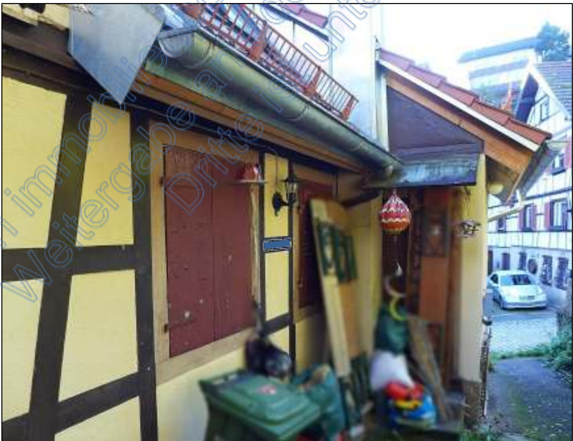
Bild 8 – Zugangsweg, Blick zurück auf den Anbau (1958)
