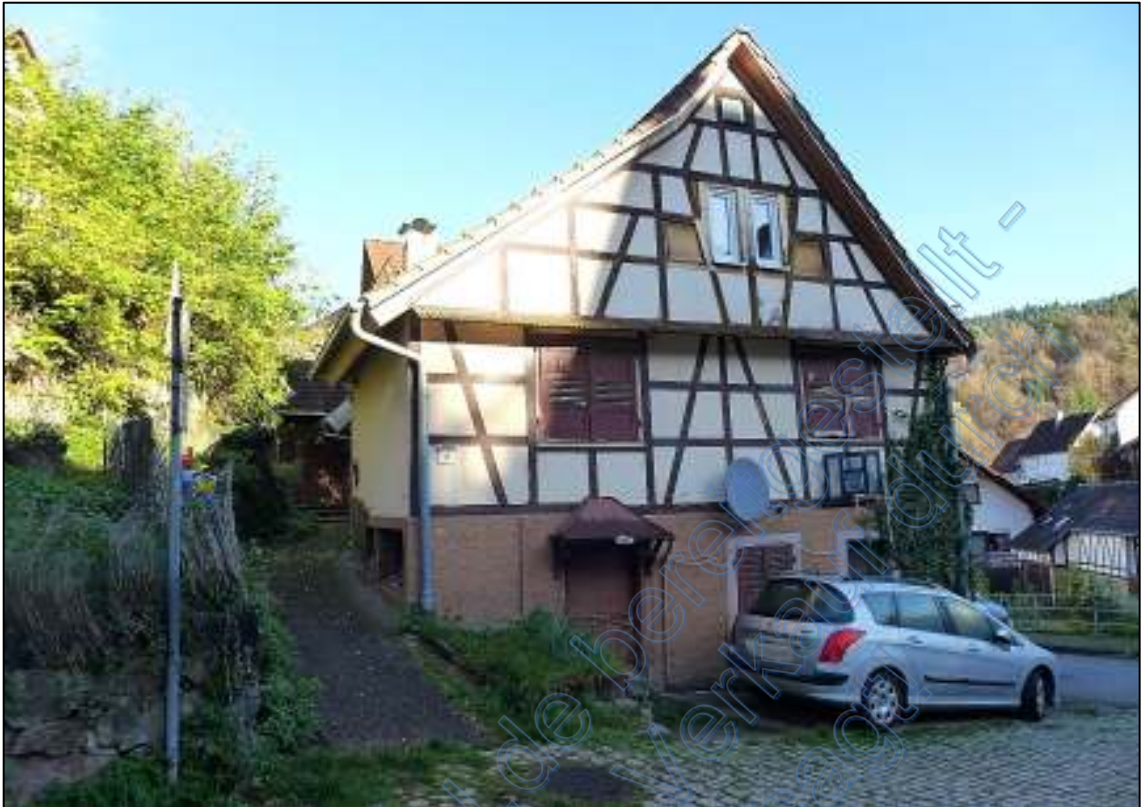
Bild 5 – Zugang zum Haus auf der Westseite
