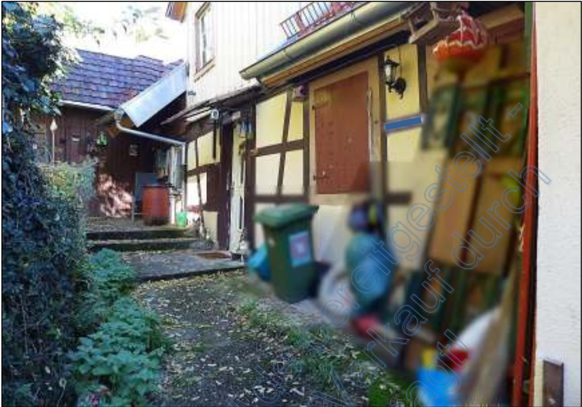
Bild 7 – Eingangsbereich mit Haustür
