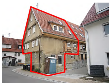
Nordwestansicht Whg. 16 rot umrandet
