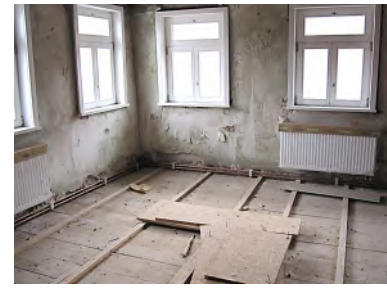
Wohnzimmer Obergeschoss, geringe Raumhöhe
