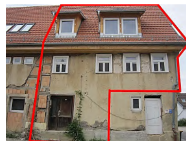
Ostansicht Whg. 16 rot umrandet
