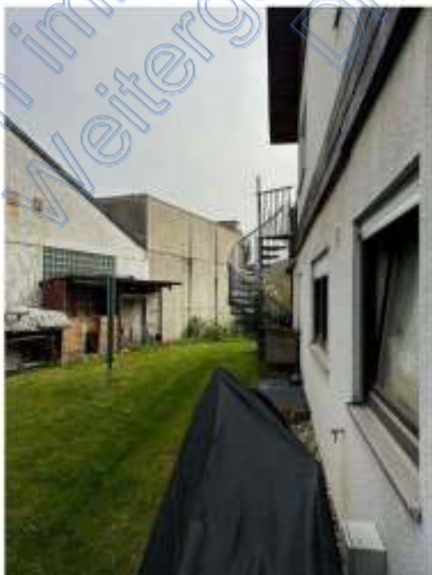
Abbildung 1: Blick auf Grenzbebauung
