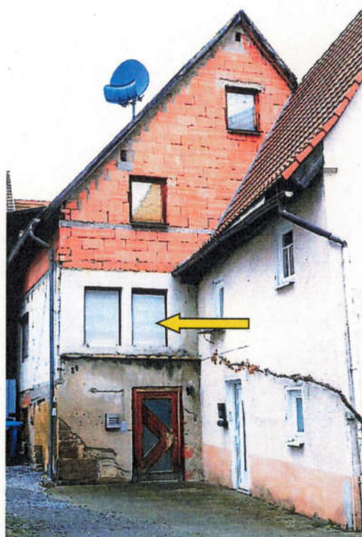
Sicht auf das Wohnhaus von Südosten. Der gelbe Pfeil zeigt auf die beiden Fenster des Wohnzimmers.
