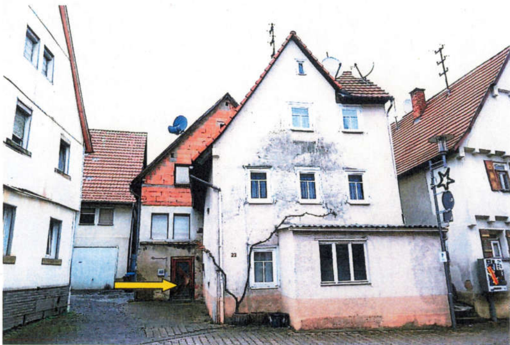
Blick auf das Wohnhaus mit zwei Wohneinheiten. Der gelbe Pfeil zeigt auf den Hauseingang über welchen die zu bewertende Wohnung zugänglich ist.
