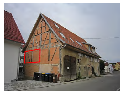
Südostansicht, Whg. 14 rot umrandet
