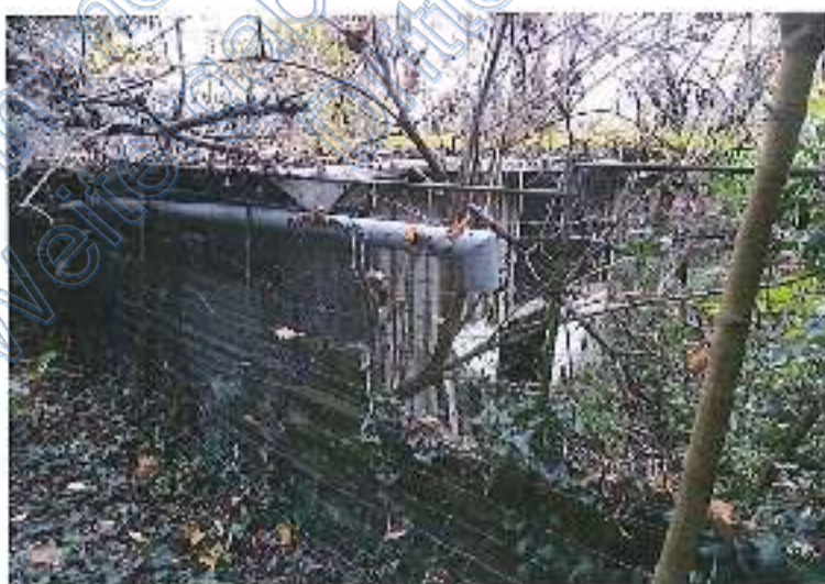
Foto 6: Alte Hütte/Stall auf Flst.Nr. 6429 (Abbruch)
