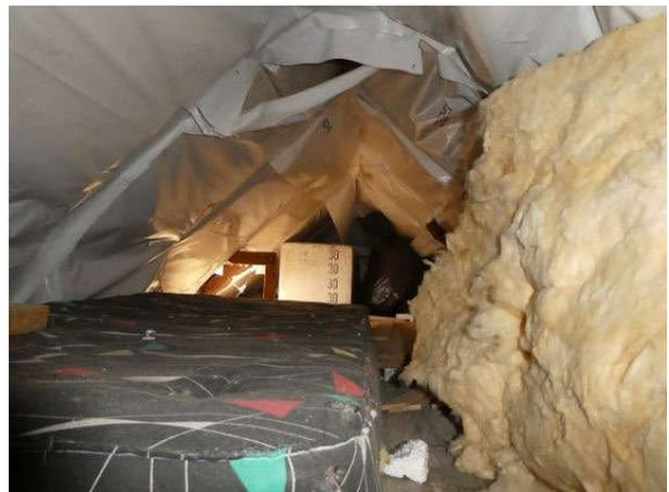
Zwischensparrendämmung vorhanden insgesamt jedoch unsachgemäß
