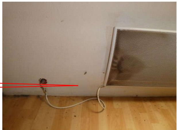
unsachgemäße Installation des Elektroheizkörpers
