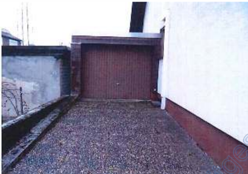
Foto 6: Garage links (Gebäude 2)
