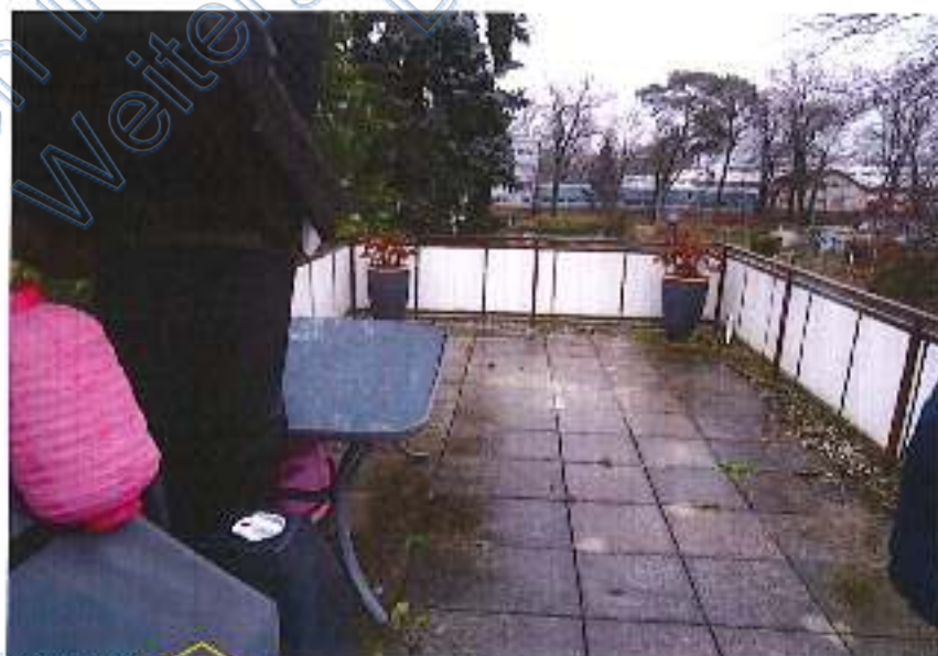
Foto 27: Dachterrasse auf dem Gebäude 3 (Garage rechts)
