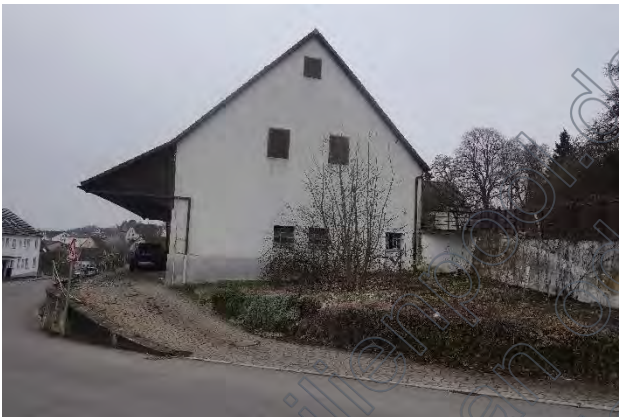
Ansicht Wirtschaftsgebäude von Nordosten
