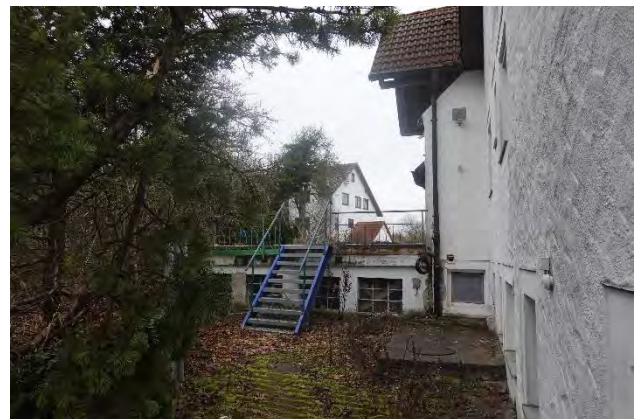
Außenanlagen, Anbau Keller
