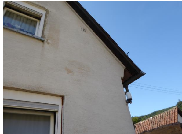
4. Nordfassade (Risse, Schäden)
