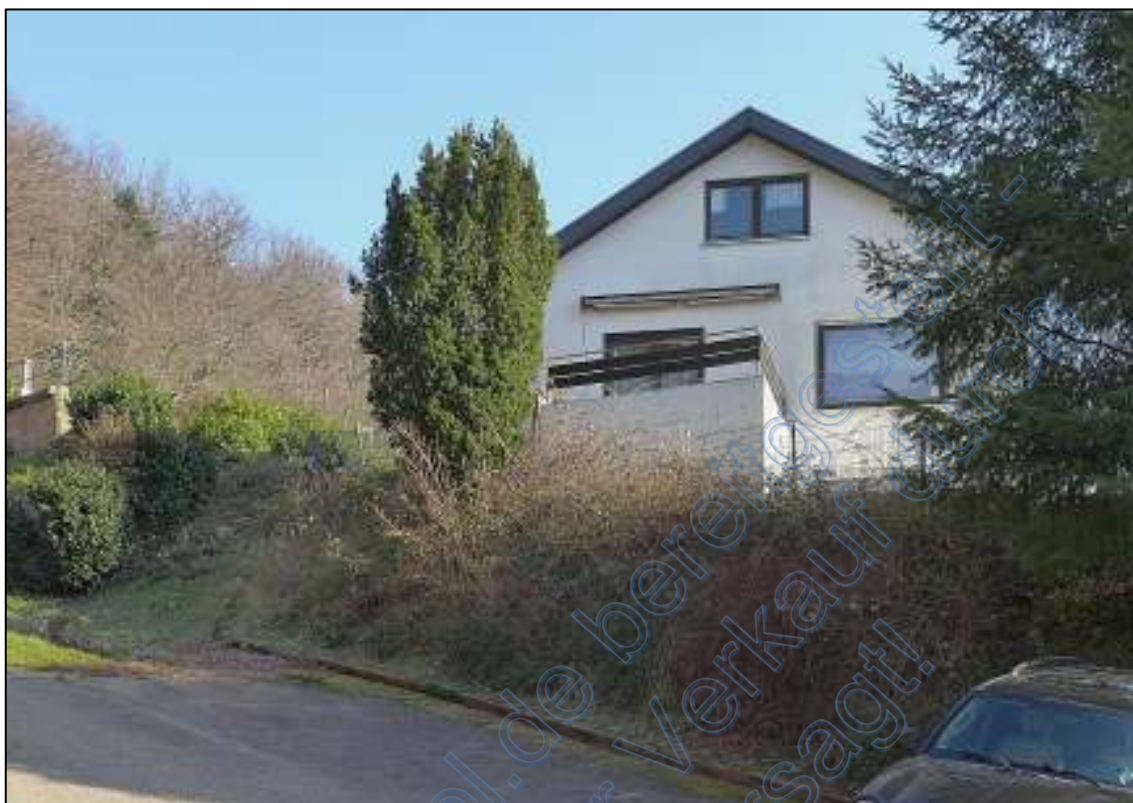
Bild 1 –Blick von Südwesten auf das Haus (von der Parkgasse aus)
