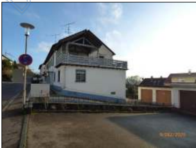
Ansicht: Westseite (Bild 3)
