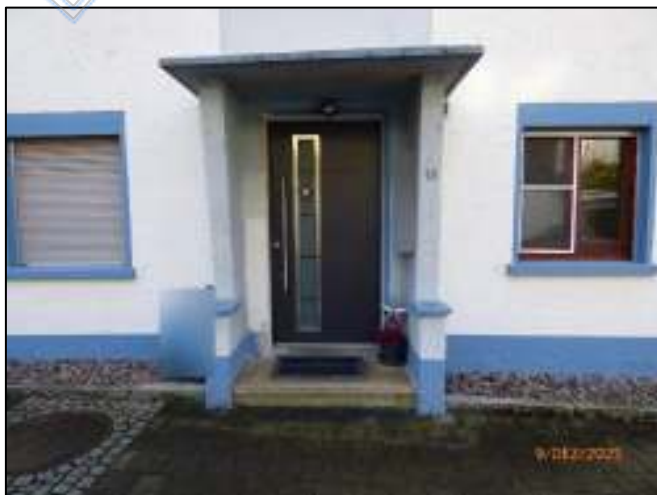
Ansicht: Hauseingang (Bild 9)
