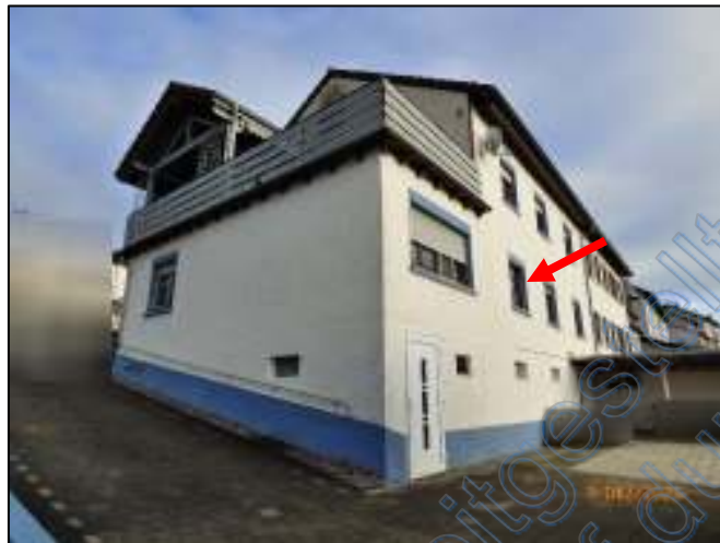
Ansicht: Südseite Kellerausgang (Bild 4)
