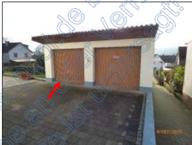
Ansicht: Garage Nr. 2 (Bild 5)
