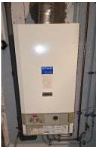
Gasetagenheizung im Keller
