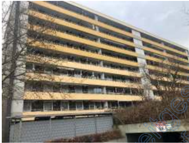
Foto 1: Ansicht Ost, Humboldtstraße 19 und 21, Zugangsseite
