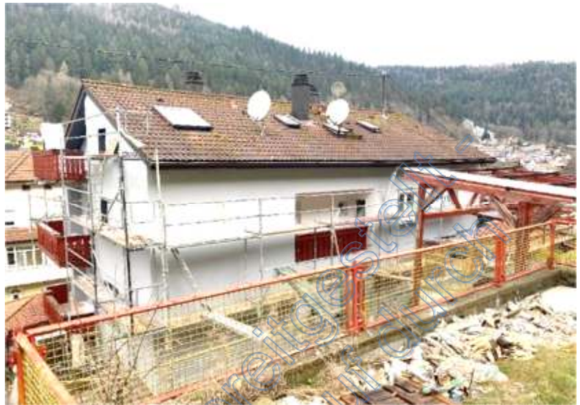
Foto 3 des SV: Ansicht von Südosten, Hausrückseite
