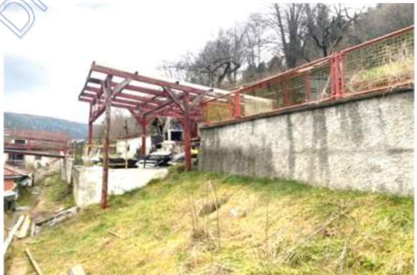
Foto 5 des SV: Überdachung im nordöstlichen Grundstücksbereich
