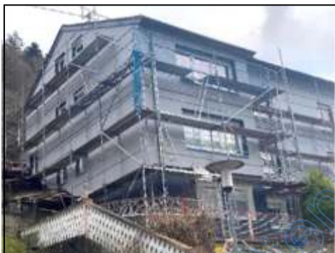
Mehrfamilienhaus (4 Wohneinheiten) mit Garagen
