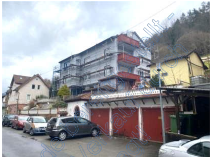
Foto 1 des SV: Ansicht von Südwesten; von der Laienbergstraße
