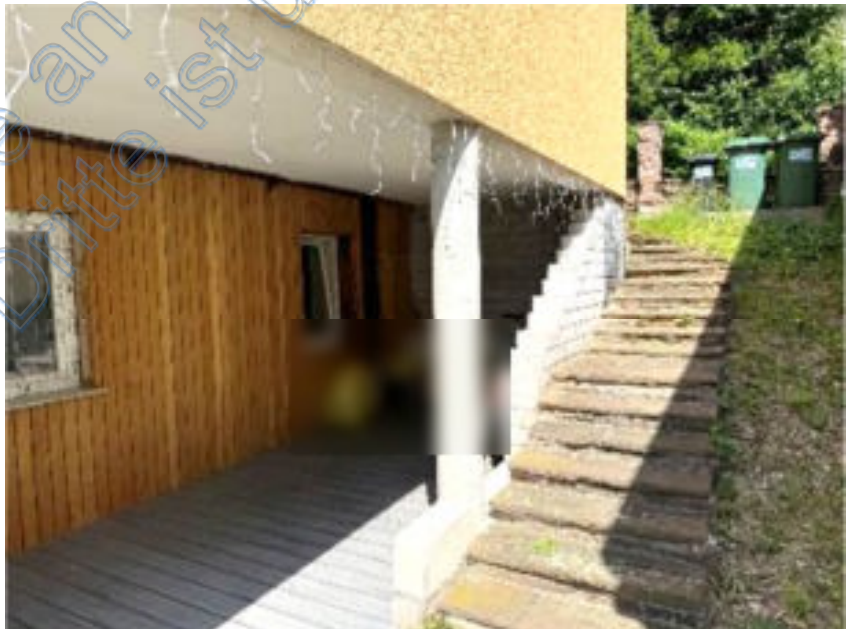
Foto 6 des SV: Zugang zur Wohnung 1 in UG/EG
