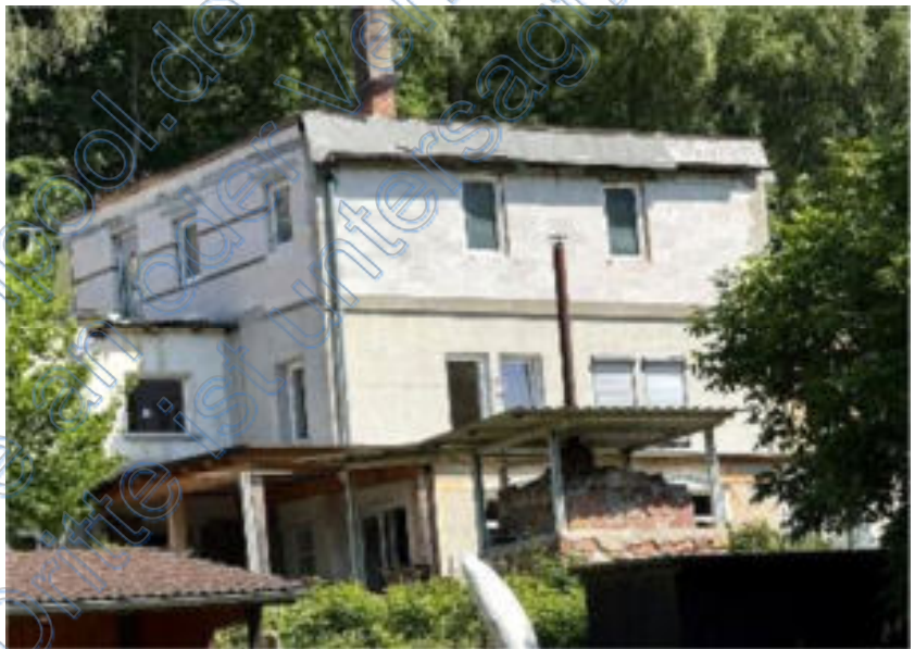
Abb. 3: Foto des SV; z.T. Fassade/Dach nicht fertiggestellt
