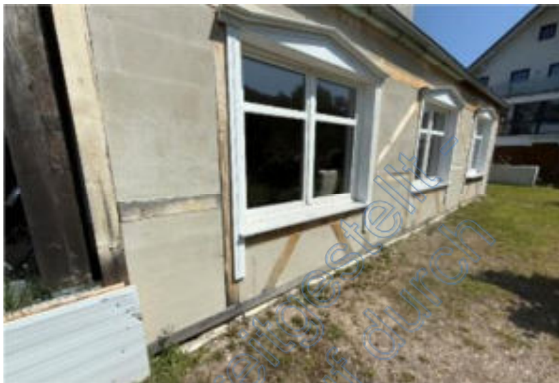
Abb. 4: Foto des SV; z.T. Fassade nicht fertiggestellt
