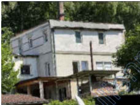
Wohnhaus mit Garage (nicht fertiggestellt)
