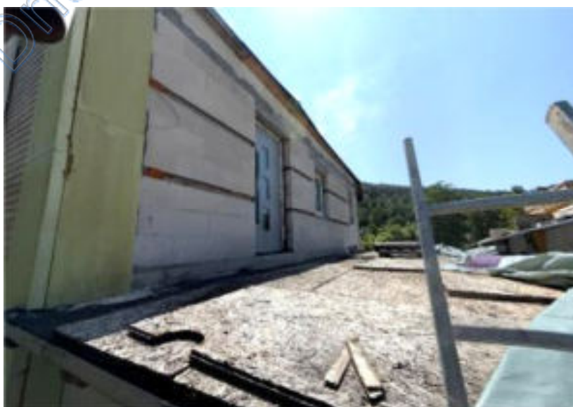
Abb. 6: Foto des SV; Eingang zum OG
