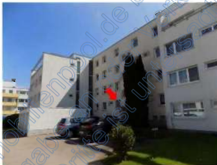
Wohnanlage, Ansicht von Nordwesten Pfeil: Eingang Hs. Nr. 22 zur der Wohnung Nr. 7
