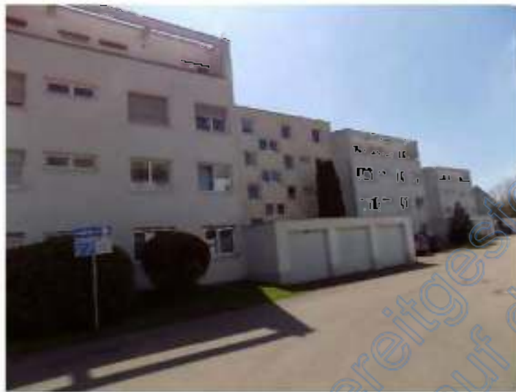
Wohnanlage, Ansicht von Nordosten
