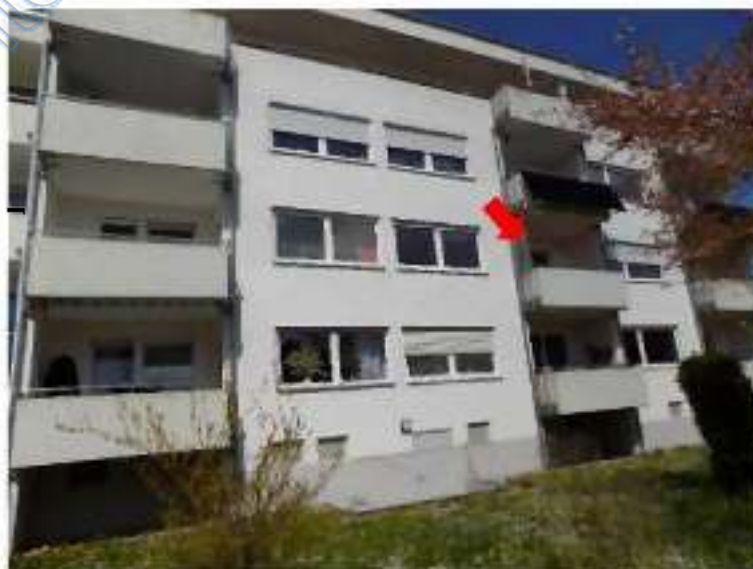
Ansicht von Südwesten, Pfeil: Balkon der Wohnung Nr. 7
