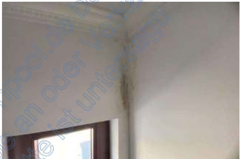
Abb. 4: Foto des SV; z.T. Feuchteschäden in Wandbereichen (Treppenhaus)
