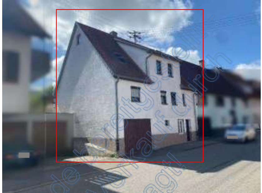
Foto 1 des SV: Anwesen Barthstraße 15, Möttlingen Ansicht von Nordosten; von der Barthstraße
