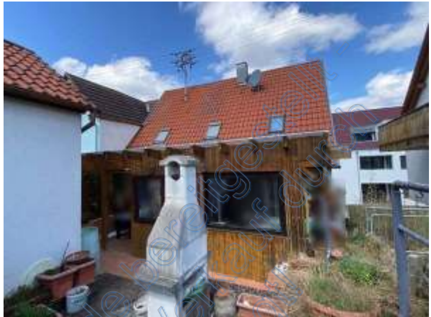
Foto 3 des SV: Ansicht von Südosten, Hausrückseite
