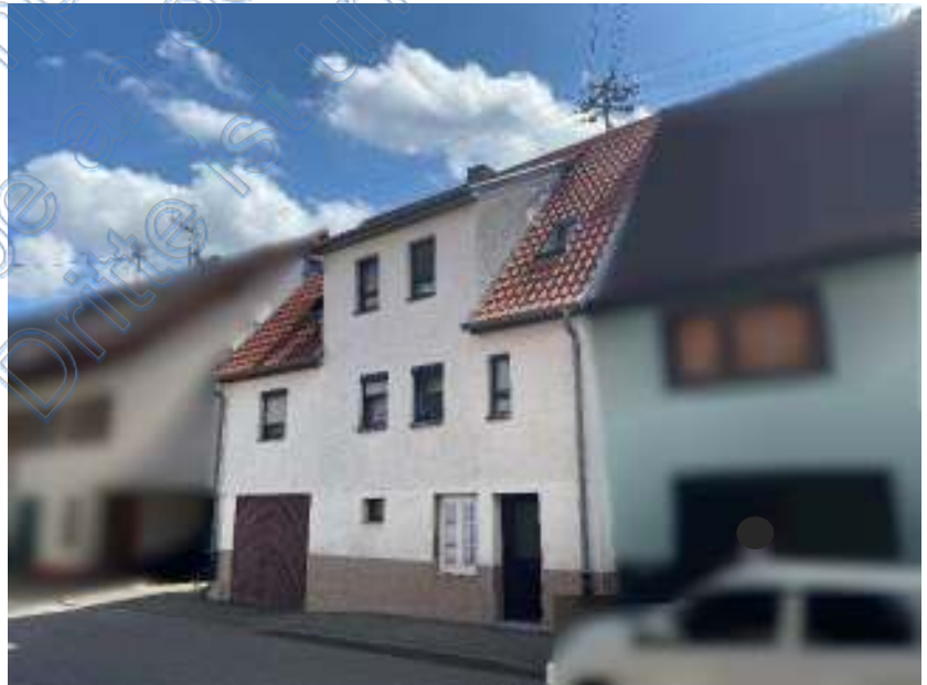
Foto 2 des SV: Ansicht von Nordwesten, Hauseingangsseite
