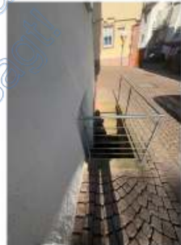
(4) Treppe zum UG an der Postgasse
