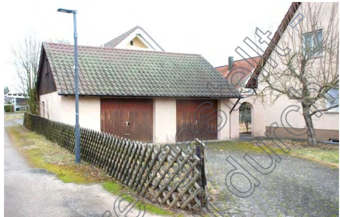
(1) Ansicht West von der Straße
