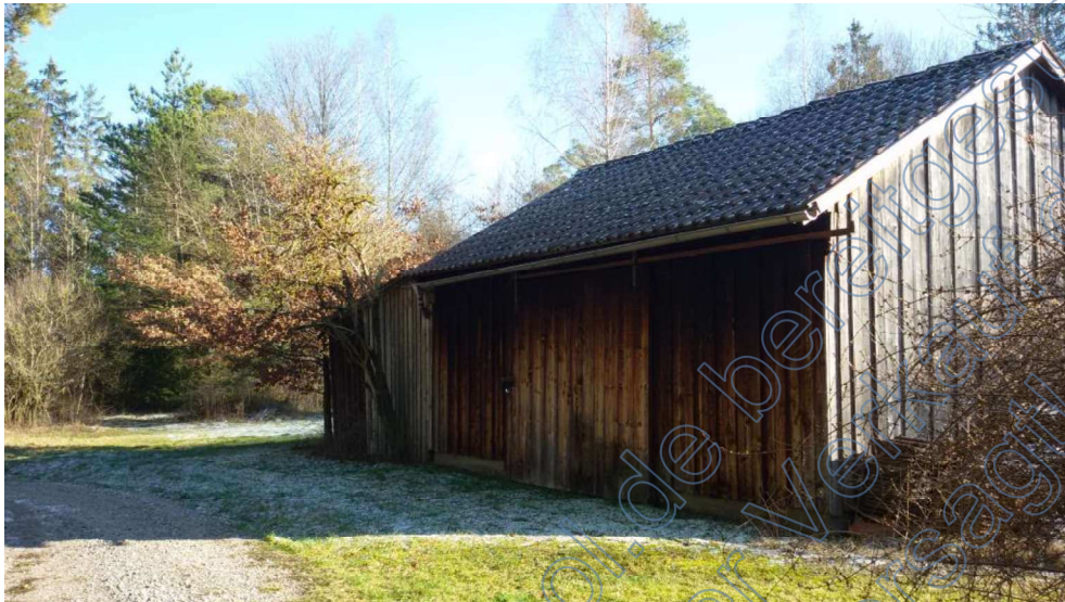
Scheune: Blick von Westen
