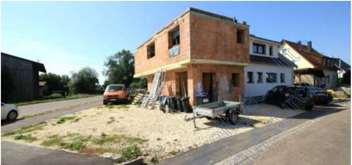
Grundstück mit 2-Familienhaus und Rohbauanbau von Nordosten, Hof im Nordosten
