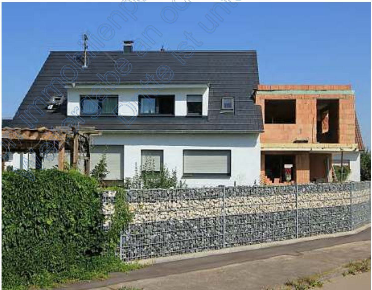
Südseite Zweifamilienhaus und Rohbauanbau; davor Nachbarzaun
