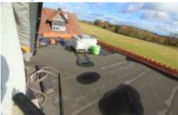
Fehlende Dachuntersicht und Bitumenabklebung Flachdachanbau
