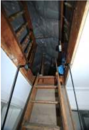
Bodentreppe zum Dachspitz
