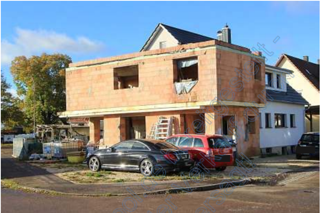
Grundstück mit 2-Familienhaus und Rohbauanbau von Nordosten
