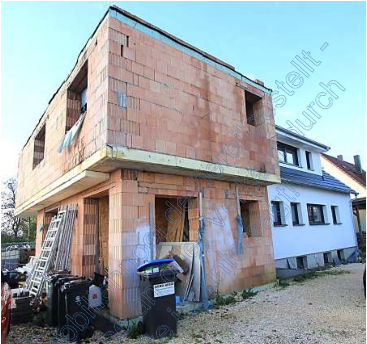
Rohbauanbau von Nordosten
