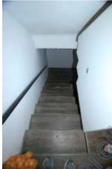
Kellertreppe von oben
