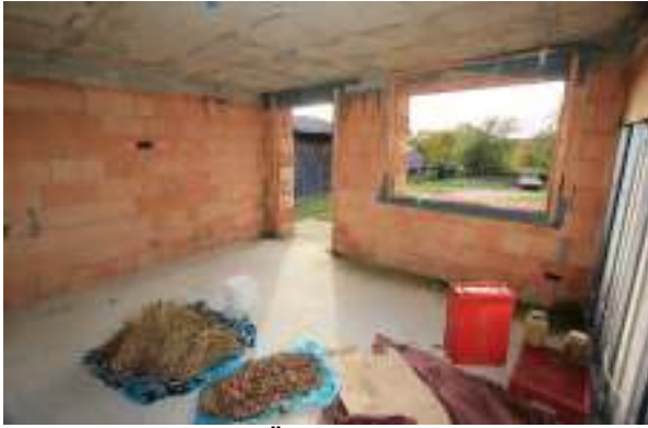
Zimmer im OG mit Öffnung zum Südbalkon
