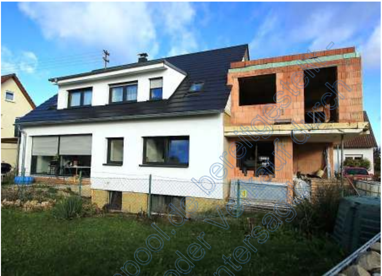
Südseite Zweifamilienhaus und Rohbauanbau
