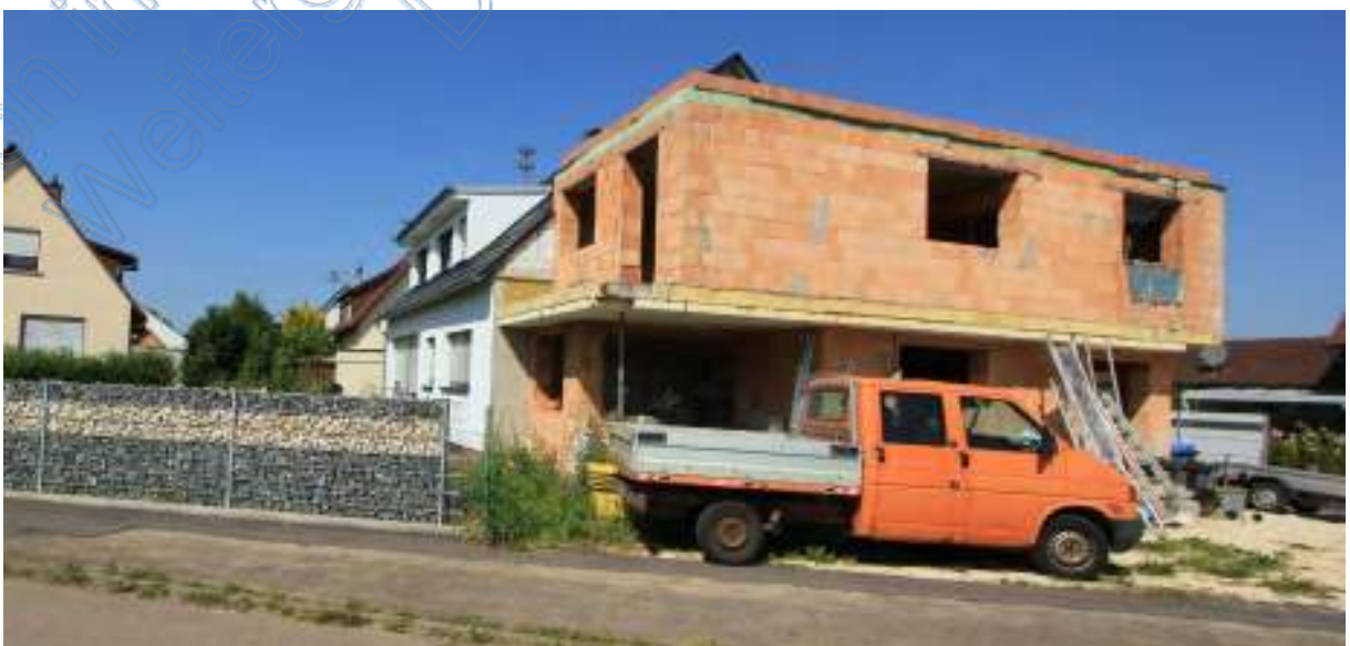
Grundstück mit 2-Familienhaus und Rohbauanbau von Ost/Südosten
