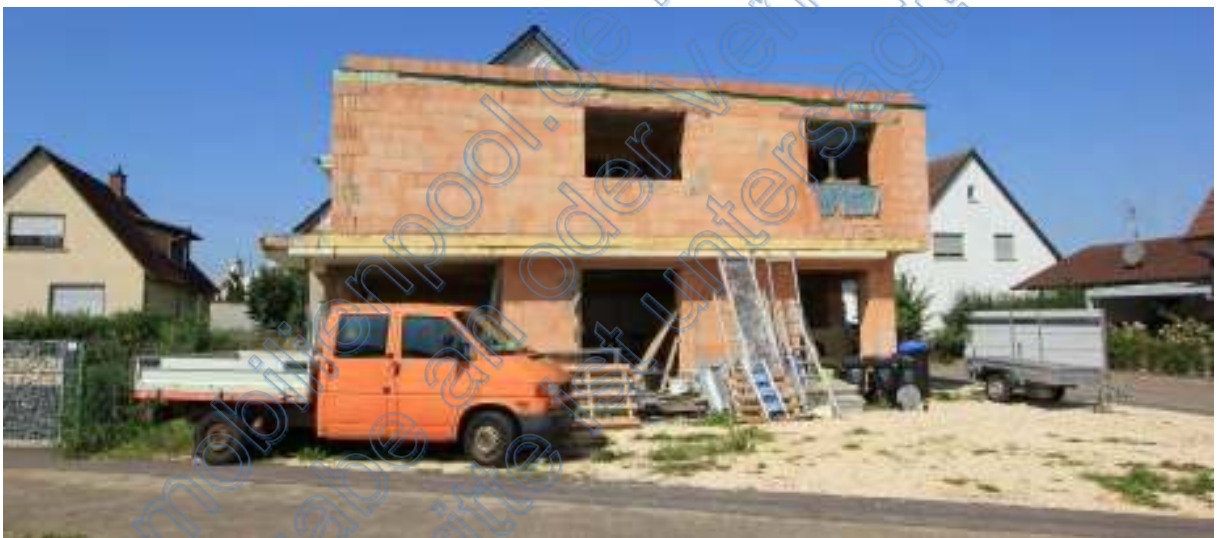
Westseite Anbau mit Aufstockung im Rohbau
