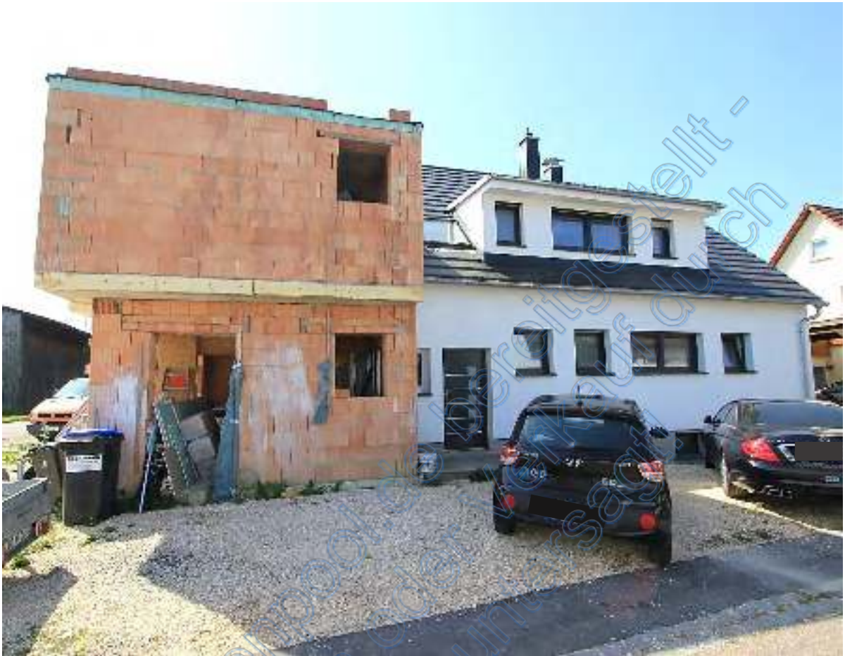
Blick von Norden, links Anbau im Rohbau, rechts 2-Familienhaus
