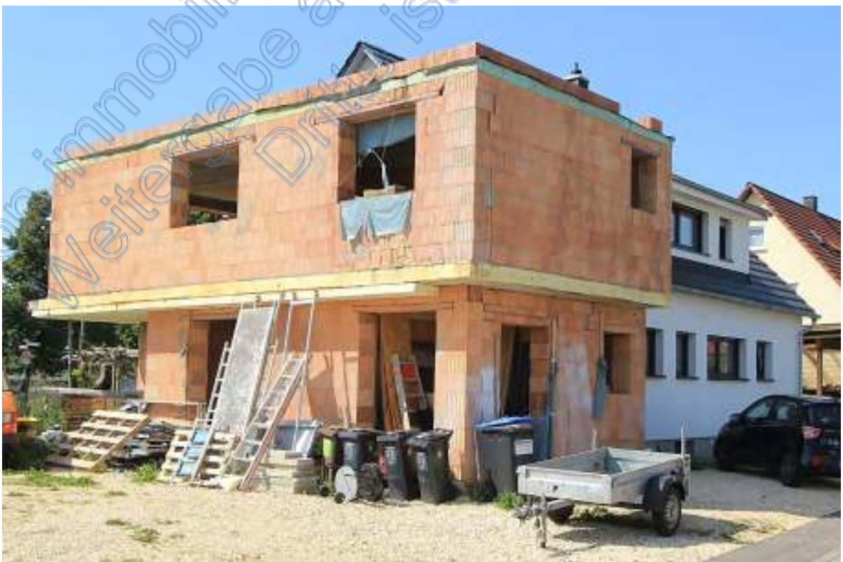
Blick von Nordosten, vorne Anbau mit Aufstockung im Rohbau, dahinter 2-Familienhaus
