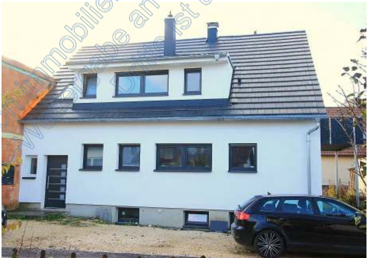
Nordseite Wohnhaus mit Haustür
