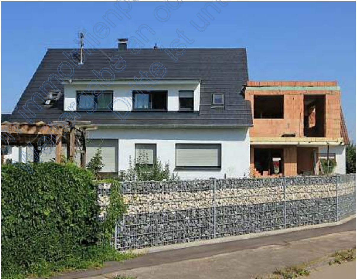
Südseite Zweifamilienhaus und Rohbauanbau, davor Nachbarzaun
