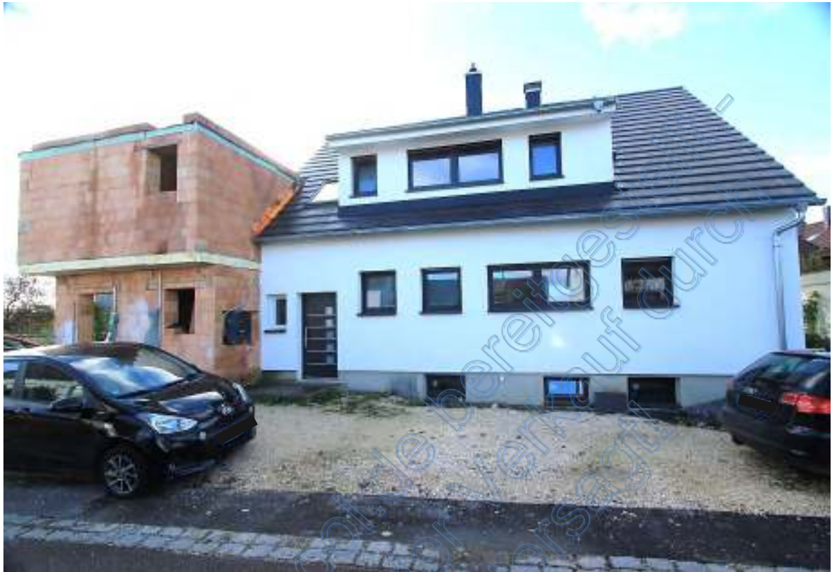
Grundstück mit Wohnhaus von Norden, links Rohbauanbau
