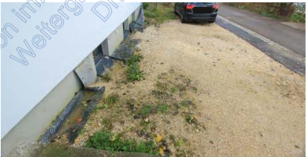
Geschotterter Hof im Norden, Sockelputzanstrich fehlt noch
