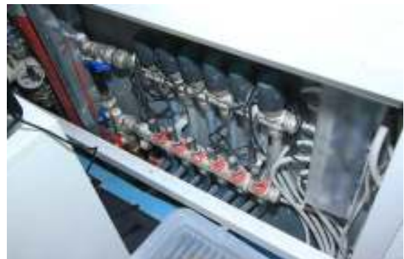
Verteiler Fußbodenheizung
