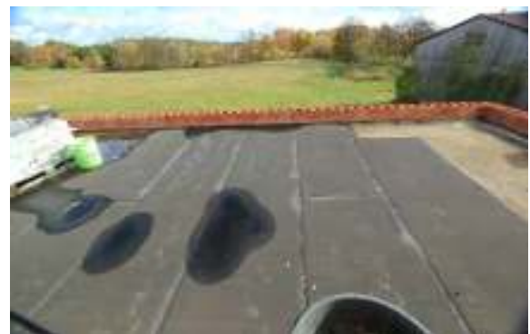
Fehlende Dachuntersicht und Bitumenabklebung Flachdachanbau
