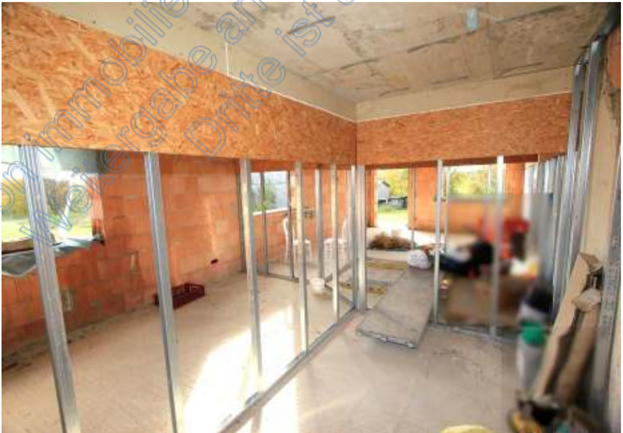
Rohbauanbau OG mit Unterkonstruktion der Innenwände
