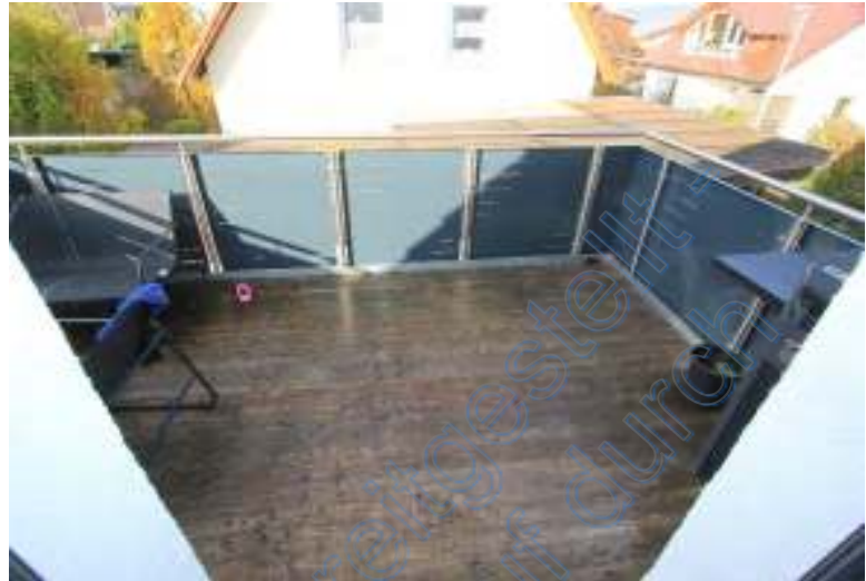
Balkon im Westen, fehlender Bodenbelag
