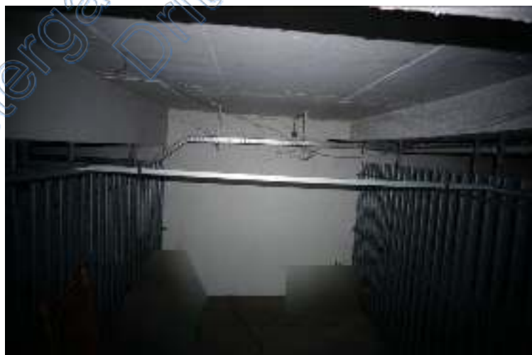
Foto 12: Tiefgarage, PKW-Stellplatz Nr. 96
