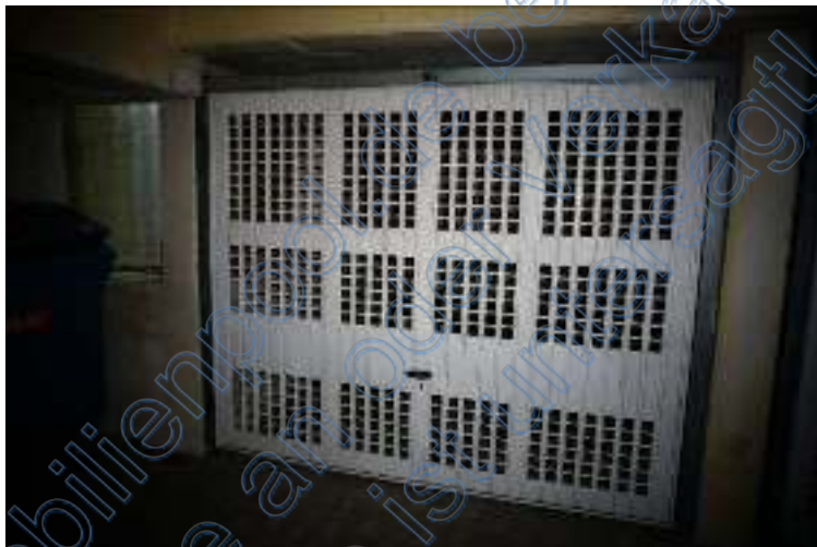
Foto 11: Tiefgarage, PKW-Stellplatz Nr. 88
