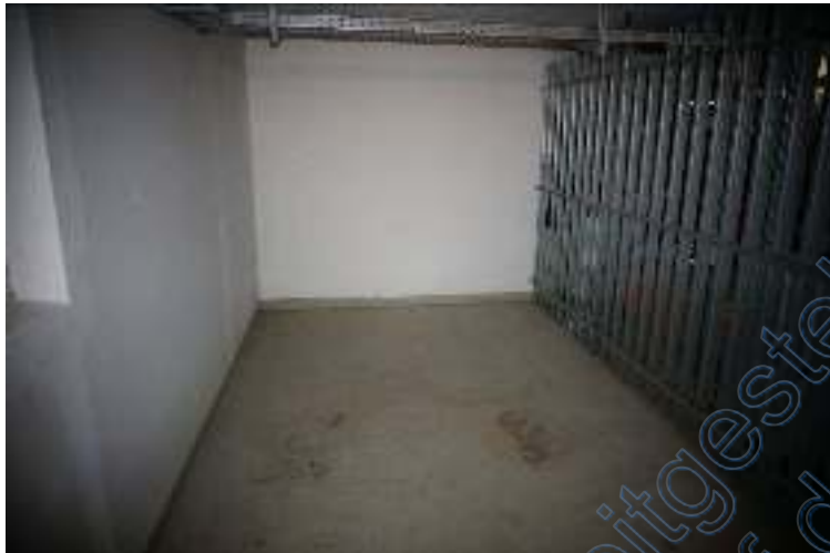
Foto 10: Untergeschoss, Abstellraum Nr. 103
