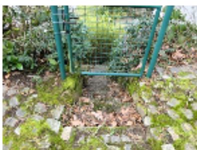
Treppe zum Wohnhaus
