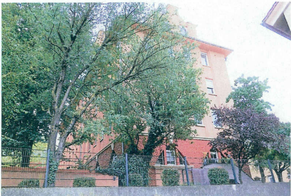
Ansicht des Gebäudes vom Nachbargrundstück aus Richtung Norden.
