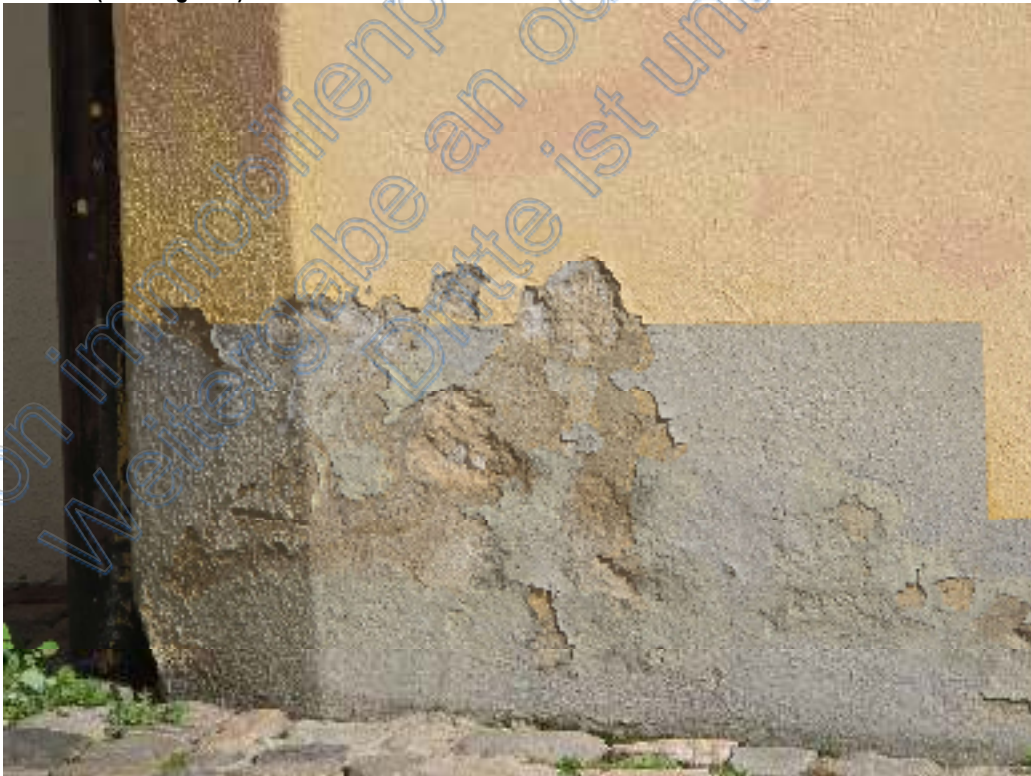
Fassade Süd - Es sind Farbunterschiede und Putzabplatzungen, insbesondere im Sockelbereich, sichtbar (Weihergasse).
