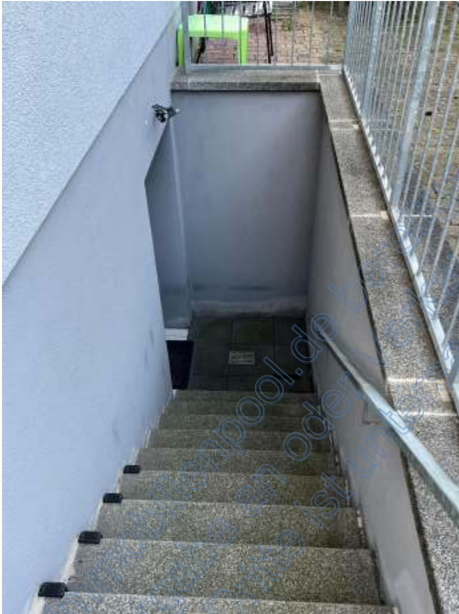
Abbildung 19: Außenliegende Kellertreppe Nordseite
