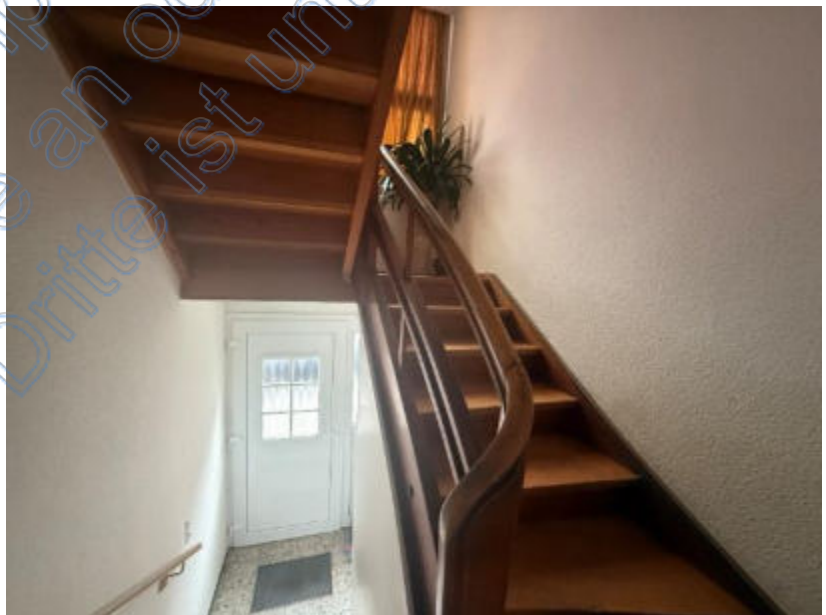
Foto 6 des SV: Hauseingang, Treppenhaus
