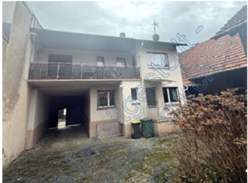
Foto 3 des SV: Ansicht von Nordwesten; Gebäuderückseite, Hof
