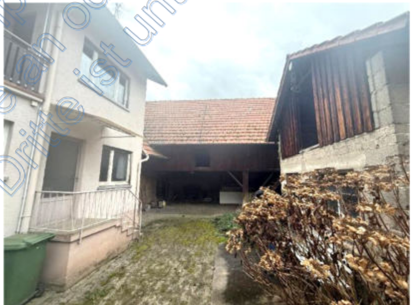
Foto 4 des SV: Ansicht von Osten; Gebäuderückseite, Schuppen (Mitte)
