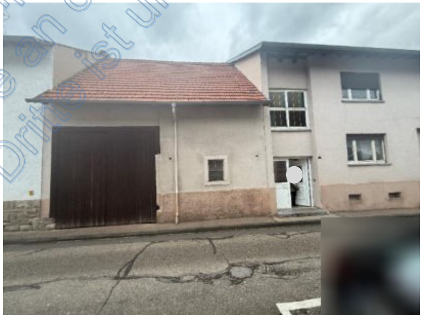
Foto 2 des SV: Ansicht von Südosten; Straßenansicht (Ringstraße), Hauseingang, Scheunenzugang
