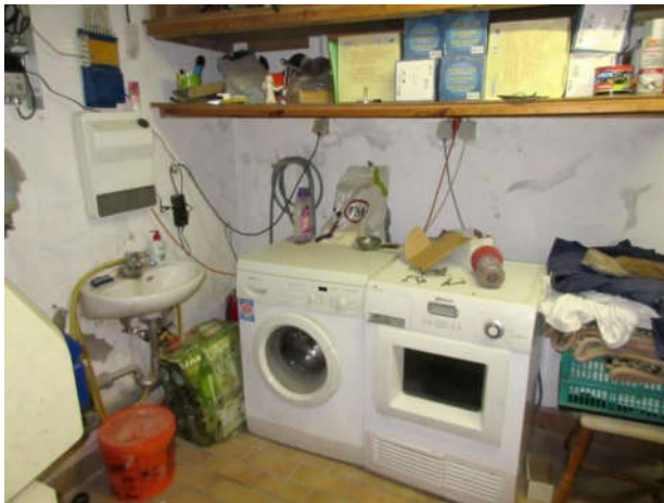
Waschraum im Kellergeschoss
