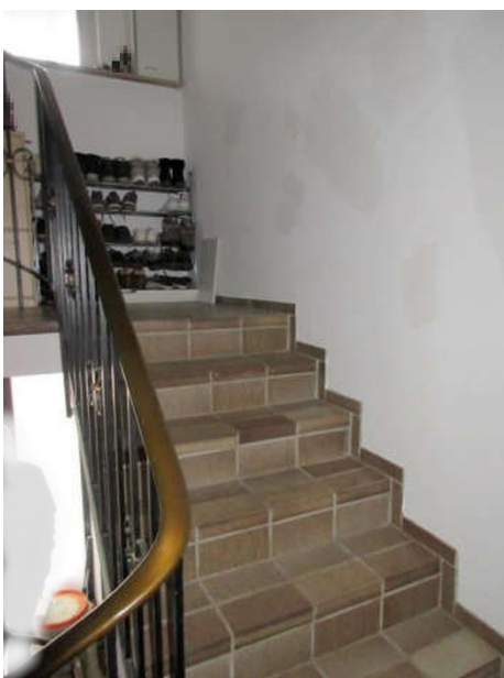
Geschosstreppe unterer Bereich
