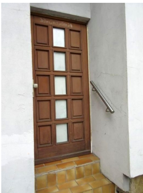
Zugangstür zur Wohnung im Erdgeschoss
