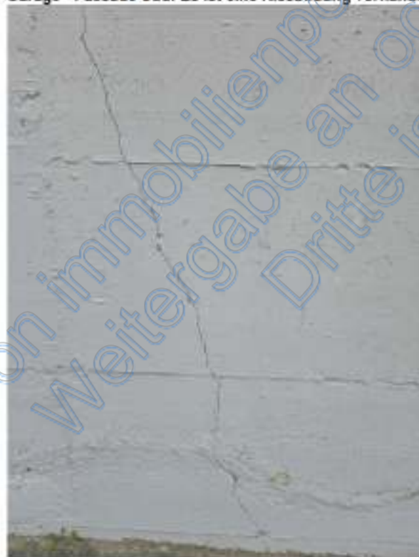
Garage - Fassade Süd: Es ist eine Rissbildung vorhanden, welche weiterhin von innen ersichtlich ist.
