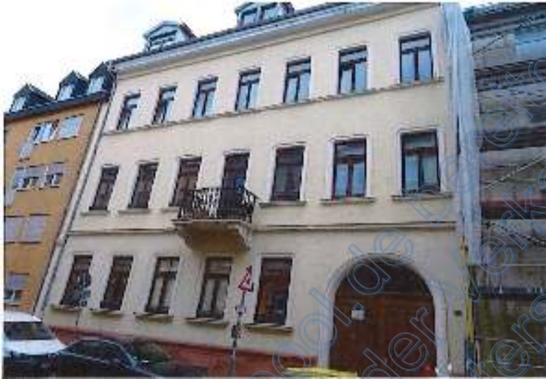
Foto 1: Ansicht von der Straße aus
