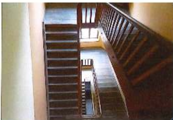
Foto 21: Treppenhaus im Vorderhaus
