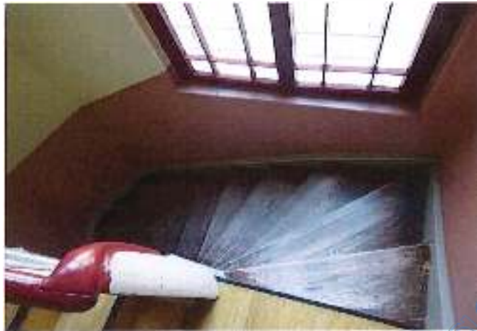
Foto 18: Treppenhaus im Seitengebäude
