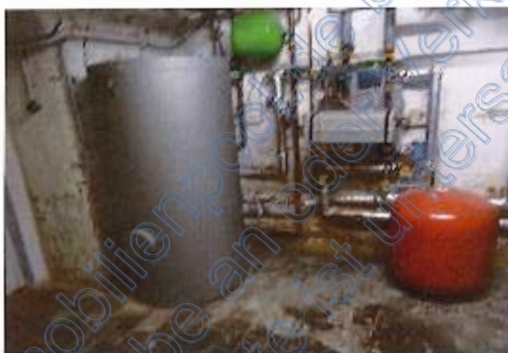
Foto 16: Ubergabestation Fernwärme
