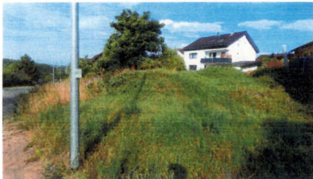
Ansicht aus Nordosten
