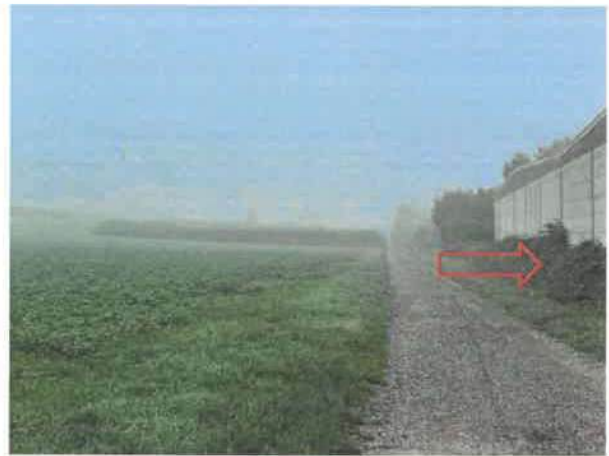
Foto 11 Mülbenweg westlich des Bewertungsgrund- stücks 4811, Blickrichtung Norden; roter Pfeil: Lagerhalle (Gebäude 4)
