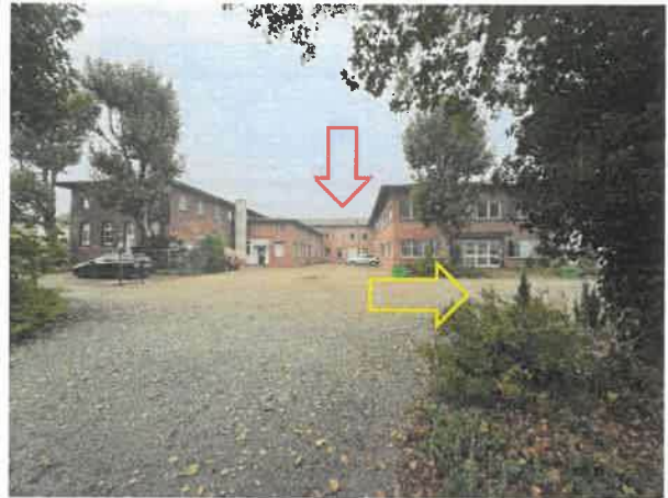
Foto 10 Blickrichtung Westen über das Bewertungs- grundstück 4811/10 (Zufahrts- und Er- schließungsgrundstück); roter Pfeil: Nach- barbebauung auf den Flurstücken 4811/7 und 4811/8; gelber Pfeil: Zufahrt zu den Be- wertungsgrundstücken 4811/9 und 4811
