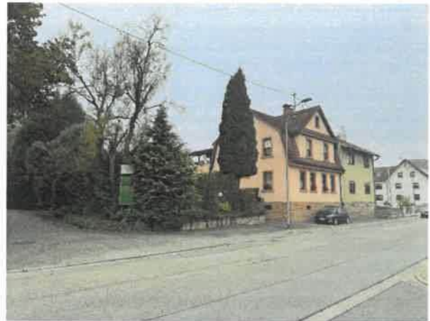
Foto 4 Industriestraße, Nachbarbebauung Richtung Norden
