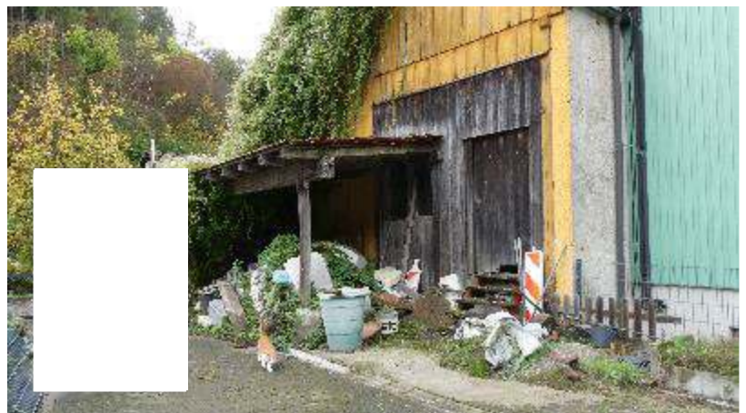
Zugang OG Scheunenteil
