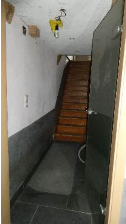
Treppe ins OG
