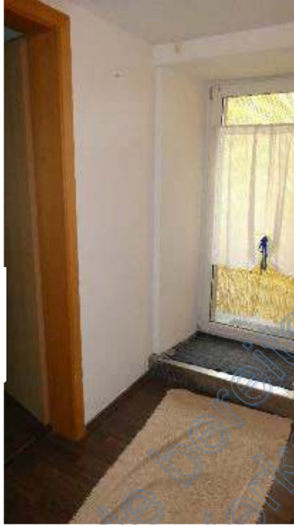
Zugang Balkon EG
