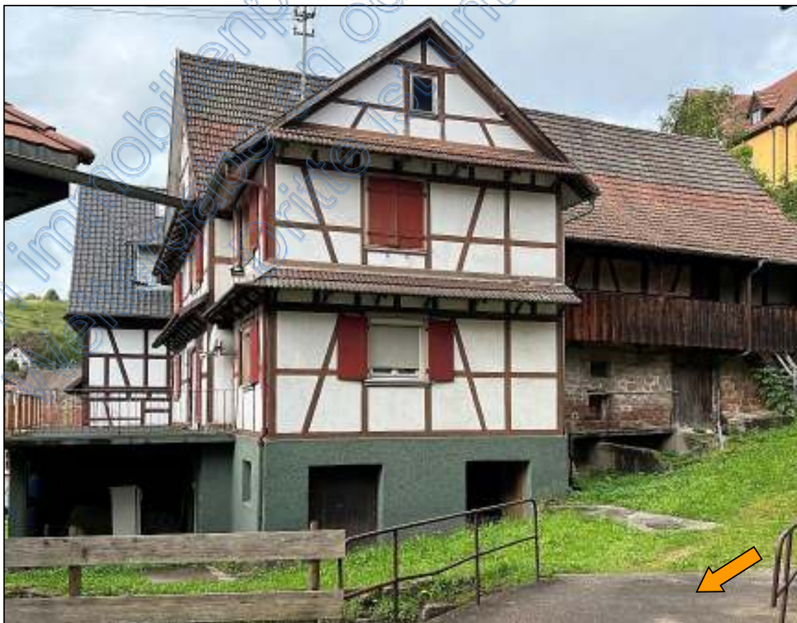
Bild 3 – Westfassade, Pfeil: Brücke über den Reichenbach
