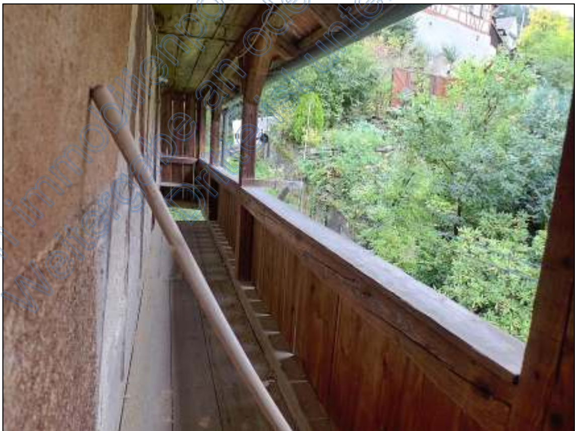
Bild 9 – Längsbalkon (Zugang) auf der Ostseite
