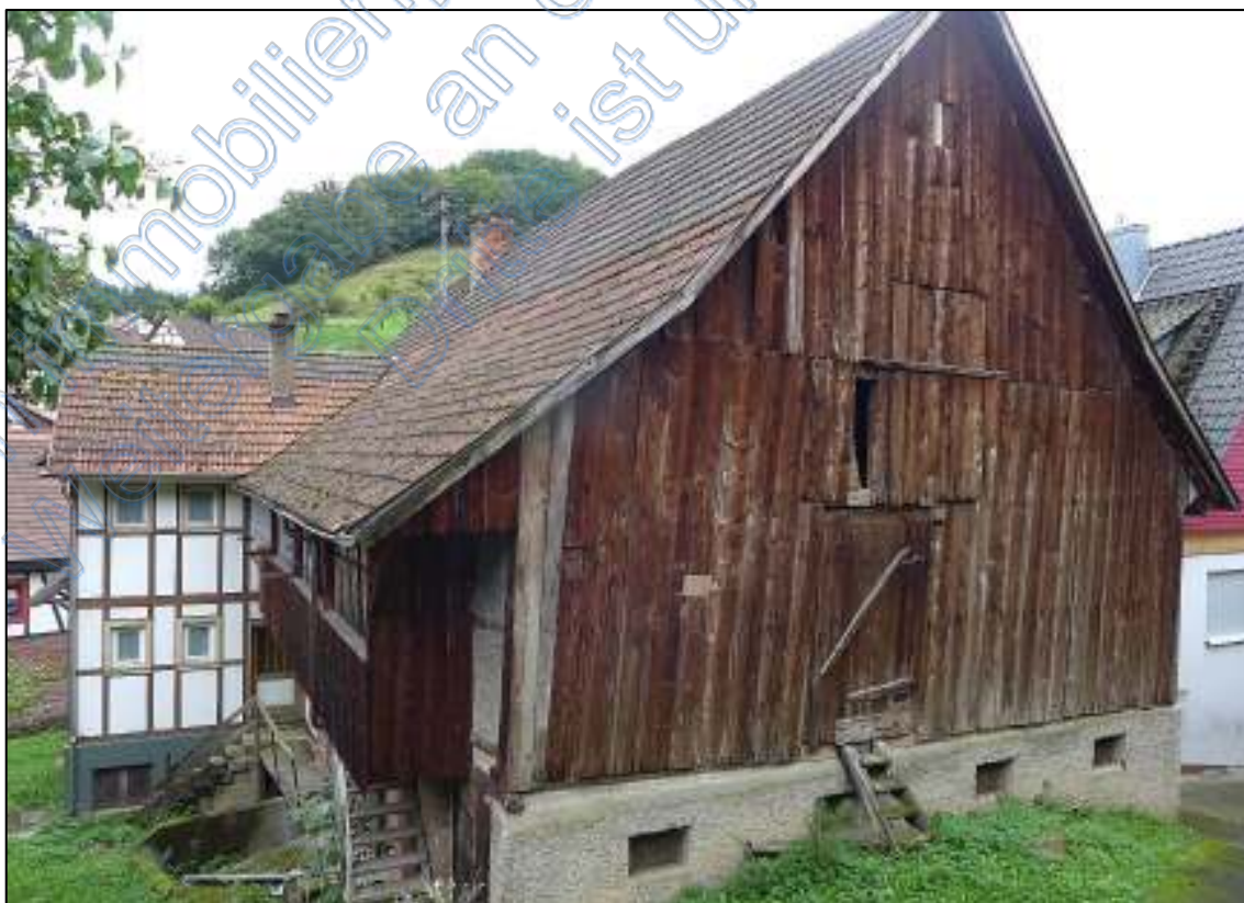
Bild 5 – Nordseite des Hauses, Ökonomieanbau
