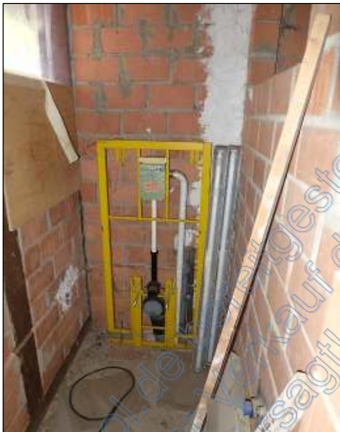
Bild 18 – Rohbaubereich im OG, künftiges WC
