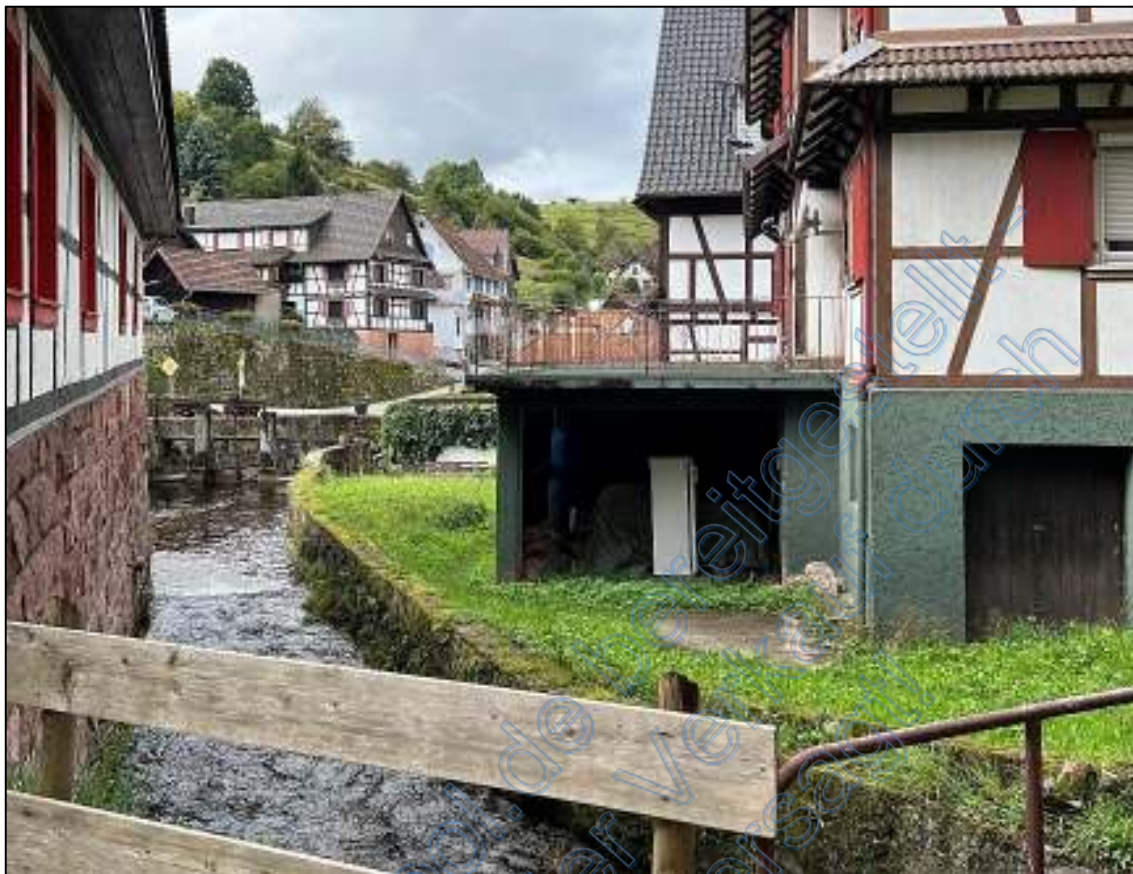
Bild 4 – Terrassenanbau zum Reichenbach hin
