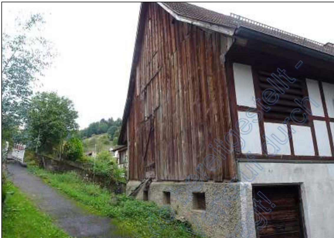
Bild 6 – Zugang zum Haus vom Ölrain aus
