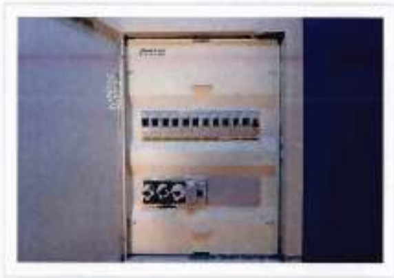
Unterverteiler Elektrik
