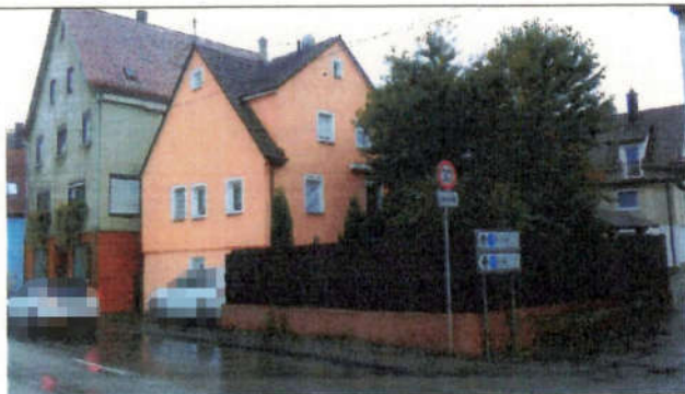
Ansicht aus Nordwesten
