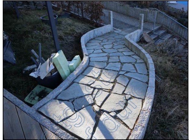
Zugangsweg Südseite zur Terrasse KG
