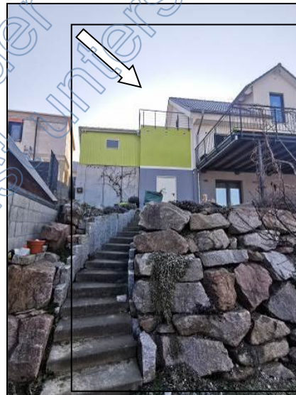
Außentreppe Westseite Garten
