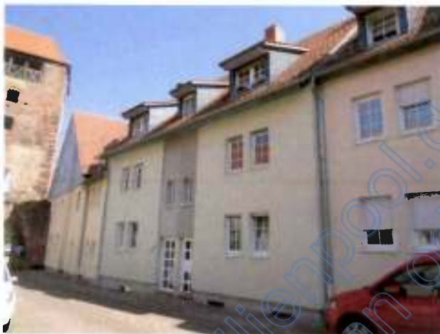
Straßenansicht Wohnanlage Wormser Str. 12 – 14a
