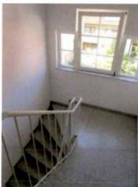
Treppenaufgang Wormser Straße 12
