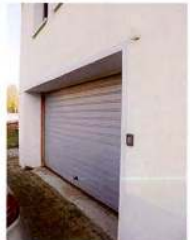
(67) Elektrisches Rolltor Garage
