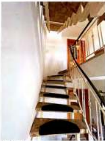
(33) Treppe zum DG Wohnung Nr. 2
