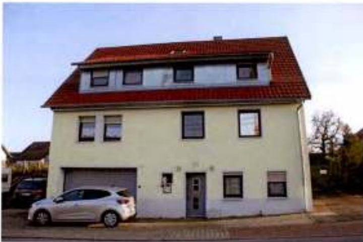
(70) 2016 Fassade gedämmt; Dach neu eingedeckt mit Verbesserung der Wärmedämmung; einzelne Fenster wurden erneuert
