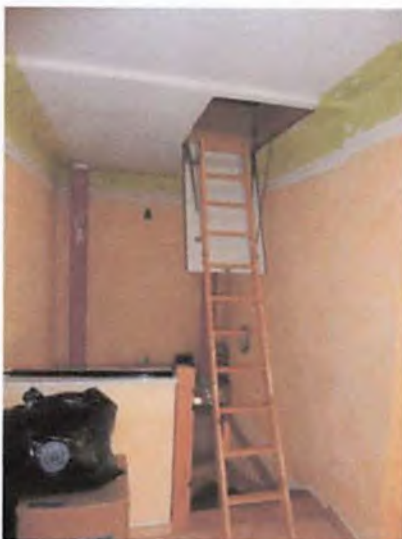
11. Einschubtreppe zum Dachraum
