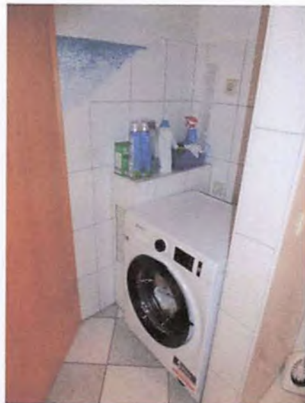
8. Bad OG (links neben der Waschmaschine Warmluftschacht vom Kaminofen)
