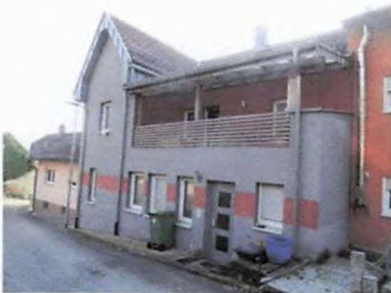
1. Blick von Nordwesten
