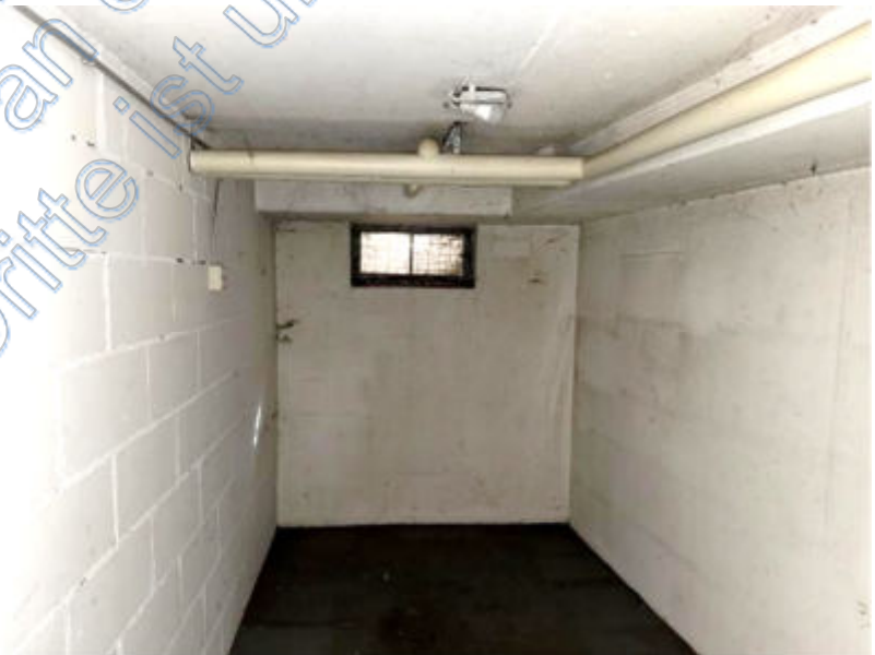
Foto 10 des SV: KG; Kellerraum Nr. K 7
