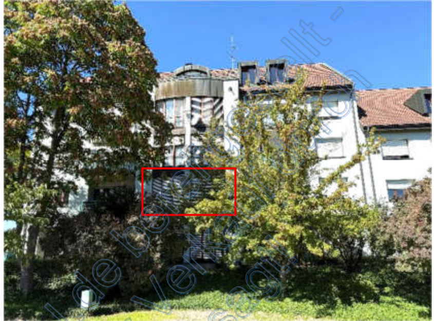
Foto 3 des SV: Ansicht von Südosten, Gebäuderückseite Haus I; Roteintragung d.d.SV: Wohnung Nr. 7
