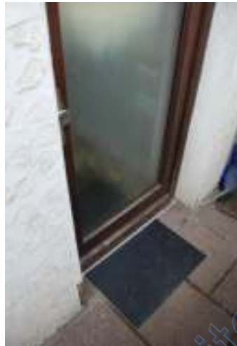
(31) Bauzustand Holzisoliertglasfenster und Türen
