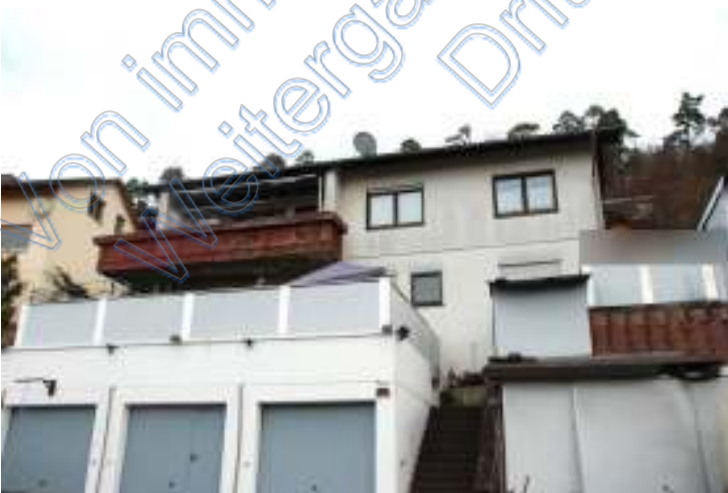
(4) Außentreppe zum UG / Hanggeschoss
