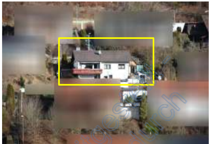
(1) Ansicht Südwest; Bewertungsobjekt markiert
