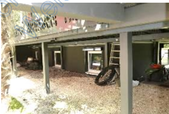
Bereich unter West-Balkonterrasse
