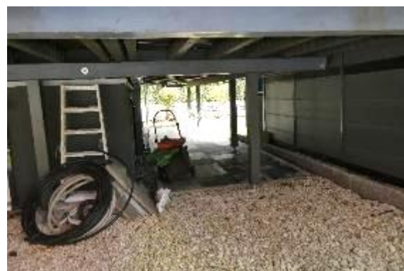
Bereich unter Süd-Balkonterrasse
